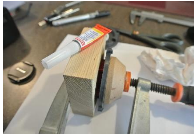
Lijmen binning / tussenring
